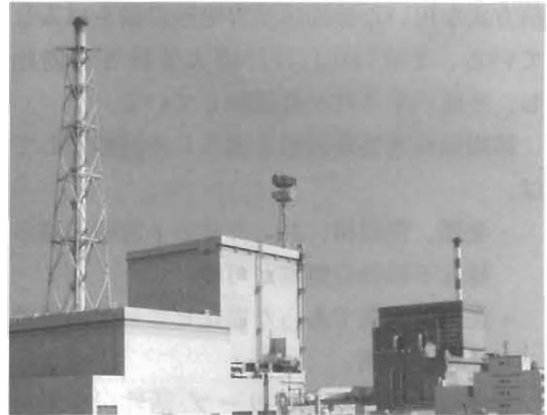
東海・東海第二発電所
