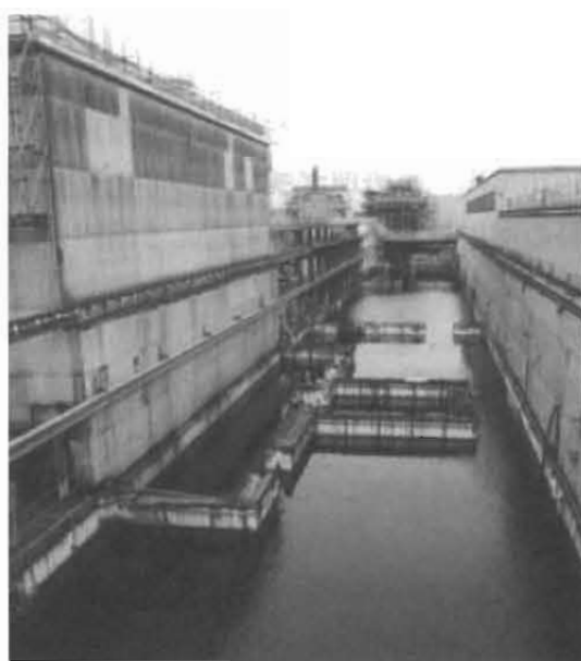
図2 屋外燃料貯蔵ポンド
