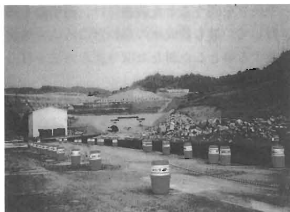
図2 処分場建設現場
